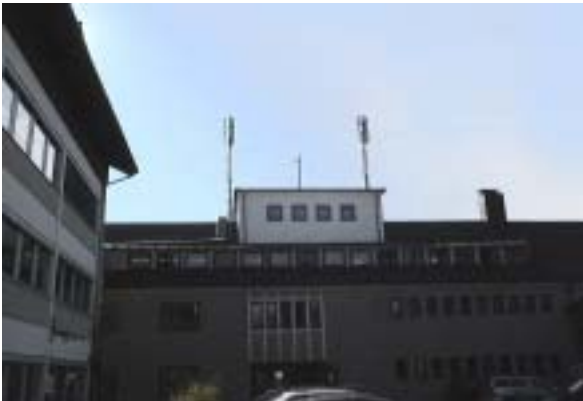
D-Netz Mobilfunkmast auf einem Betriebsgebäude
